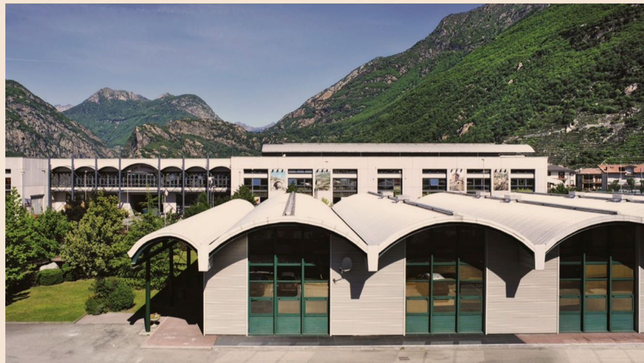
Strutture. Un'immagine dell'incubatore di impresa di Pont-Saint-Martin
